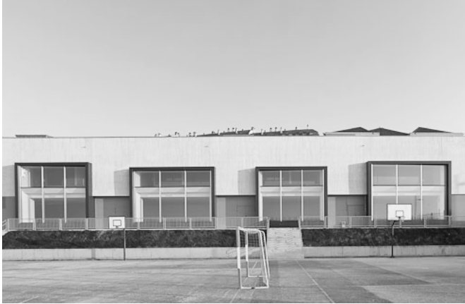
COLEGIO EMILIA PARDO BAZÁN A CORUÑA (ESPAÑA) IGLESIAS VEIGA ARQUITECTOS EQUIPAMIENTO PÚBLICO
